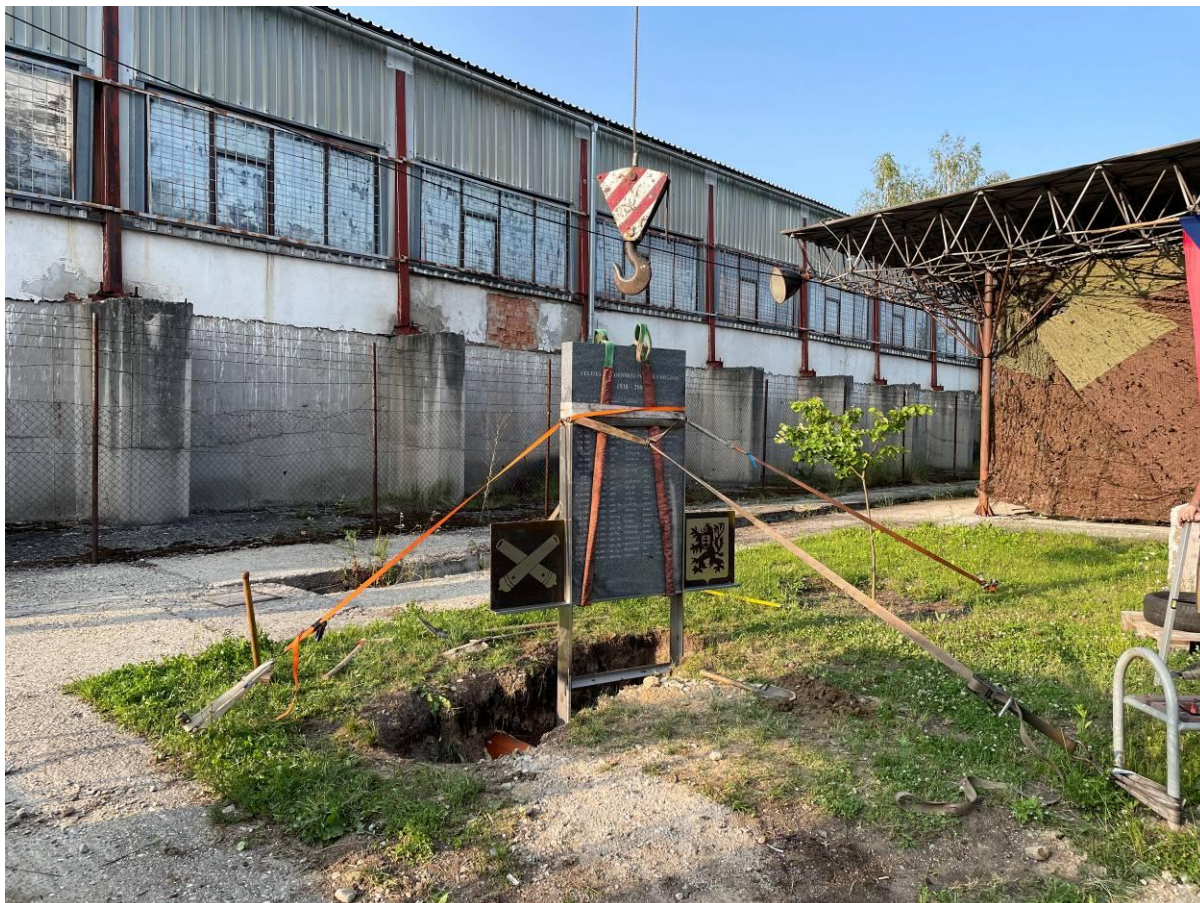
Obrázok číslo 33: Zavetrená konštrukcia stojí a čaká na betón. Foto: mjr. v.v. Ing. Martančík Miroslav.
