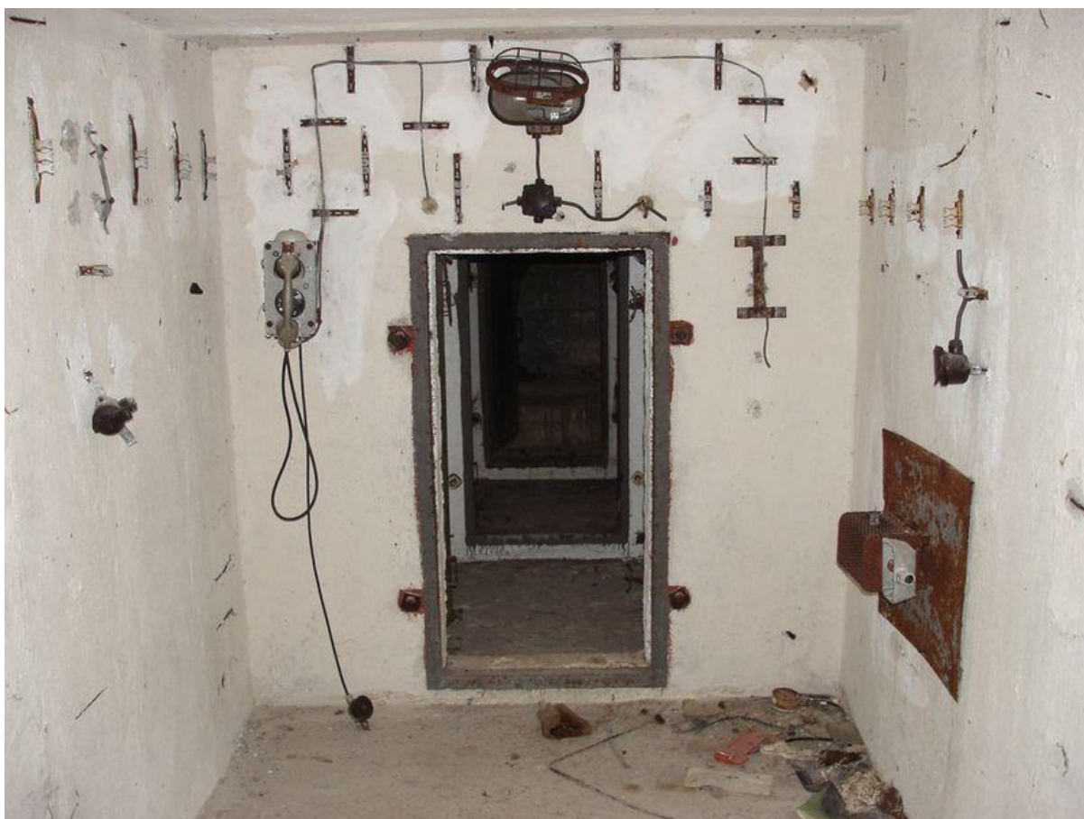
Obrázok číslo 47: Pohľad do vnútra UŽ-6, vľavo vedľa protitlakových dverí je banksý telefón a vpravo na stene je elektrický ohrievač. Foto: internet.
