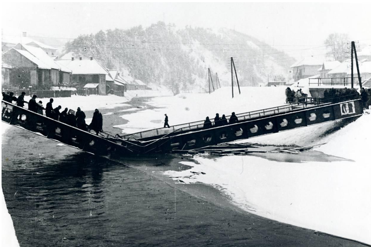
Obrázok číslo 7: Poškodená lávka cez rieku Hron. Foto: archív HMB.
